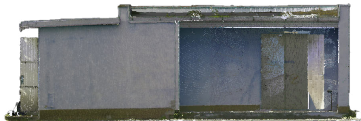
Obrázok 21: Severovýchodný pohľad na technologický objekt
