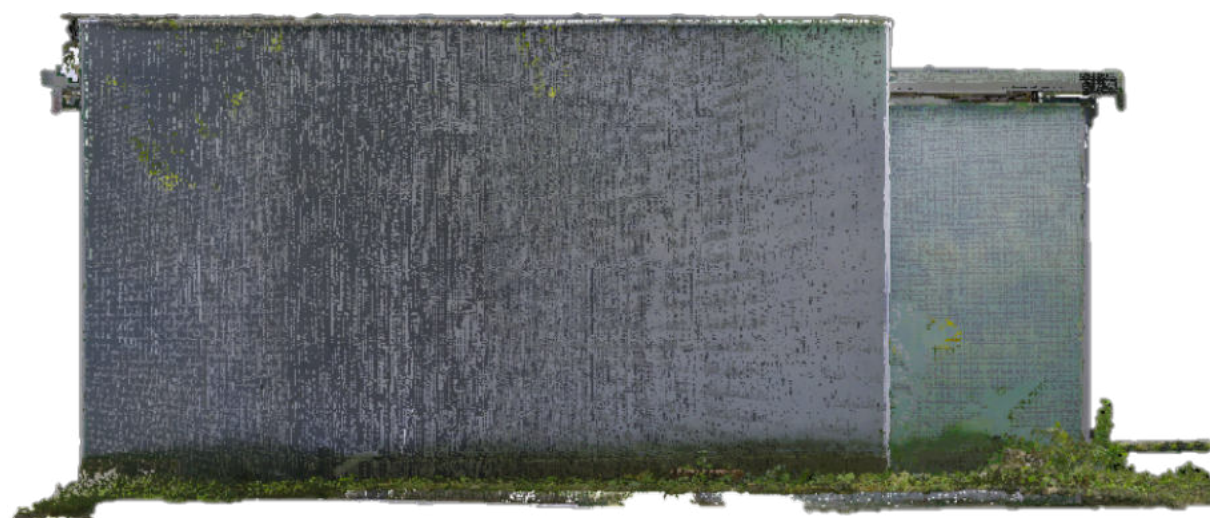
Obrázok 20: Severozápadný pohľad na technologický objekt v mračne bodov
