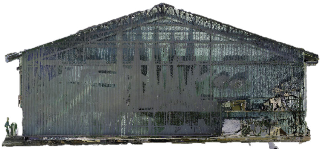
Obrázok 23: Juhozápadný pohľad na objekt skladu reziva v mračne bodov
