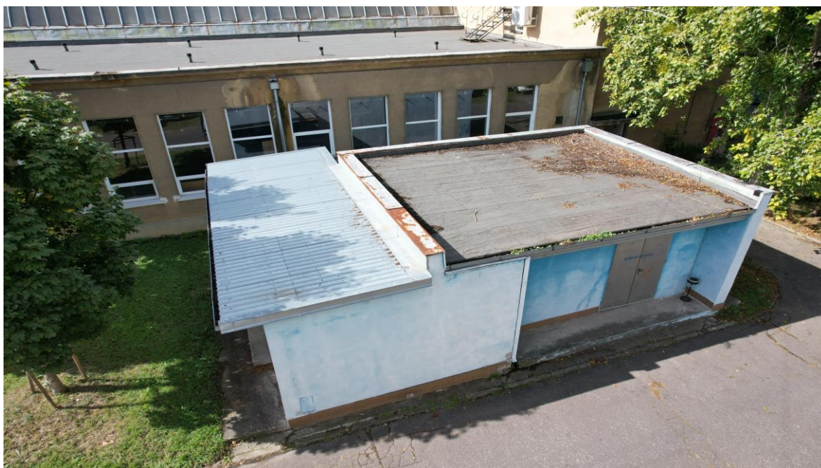
Obrázok 36: Pohľad technologický objekt – exteriér
