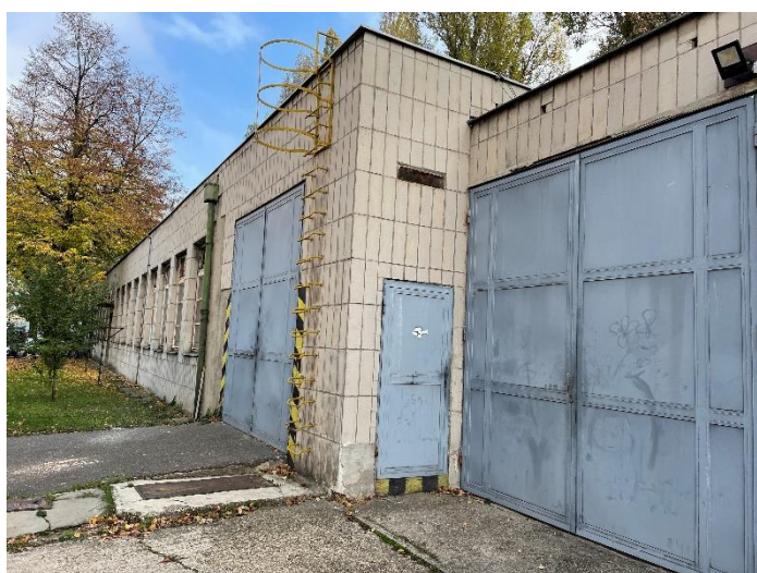
Pohľad z exteriéru na stranu práčovne
