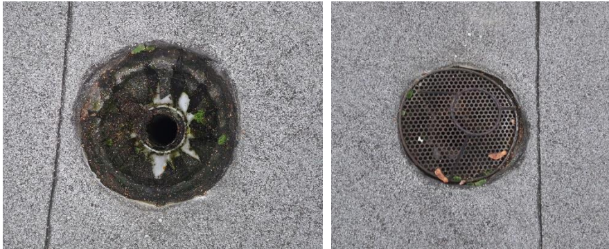
Obrázok č.3 – strešný vpust
