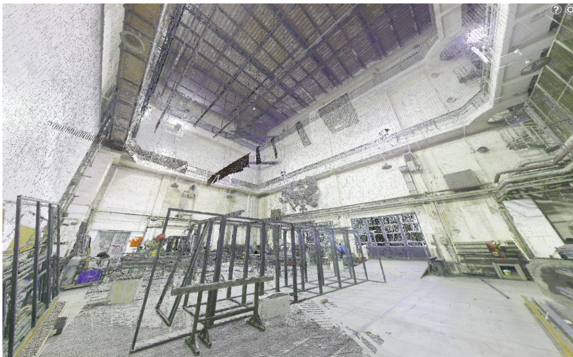
Obrázok 64: Pohľad na veľkú zámočnícku dielnu z postavenia skenera v mračne bodov
