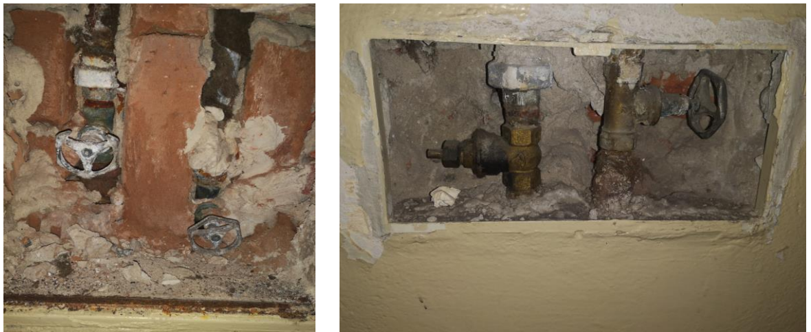
Obrázok č.2 – stúpacie potrubia v stene
