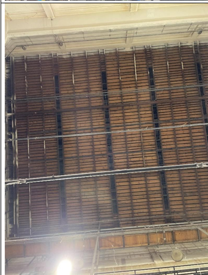
Pohľad do na strešnú konštrukciu nad zámočnickou dielňou
