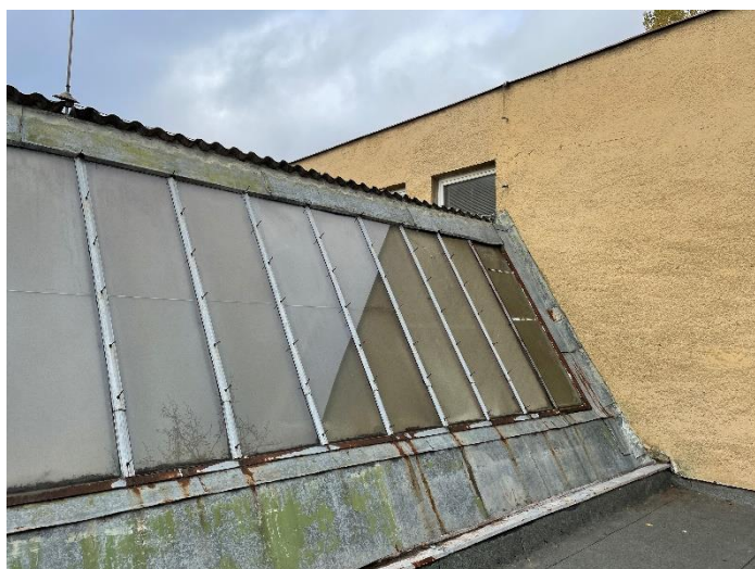
Pohľad na zasklenie strechy
