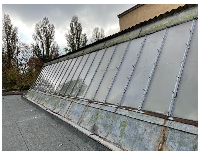
Pohľad na zasklenie strechy
