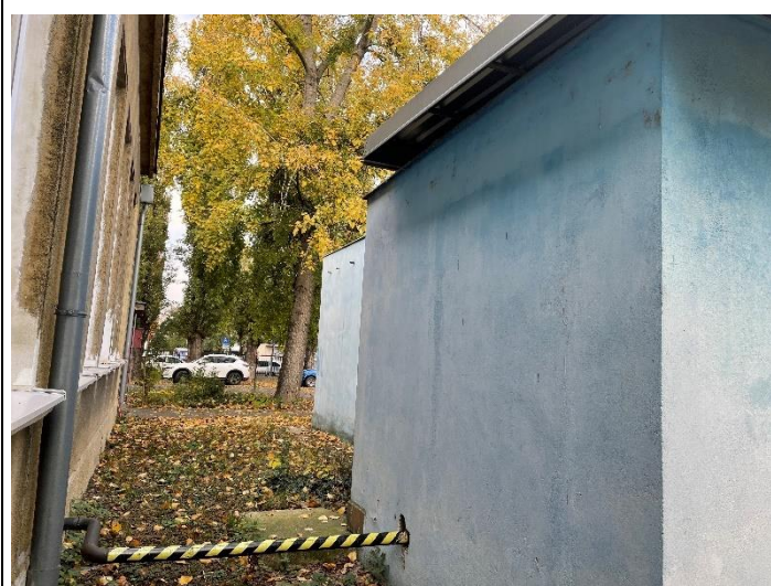
Pohľad na zadnú časť technologického objektu
