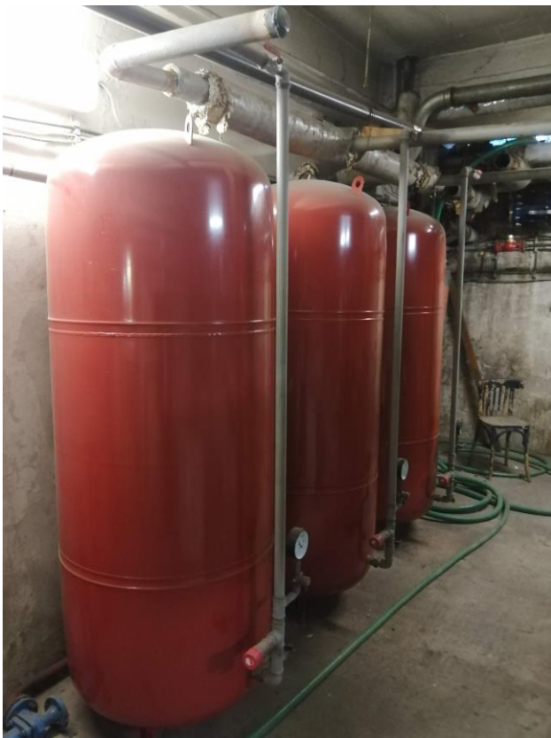
Obr. Membránové expanzné nádoby
