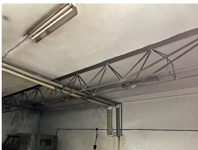
Pohľad na stropnú konštrukciu v garáži
