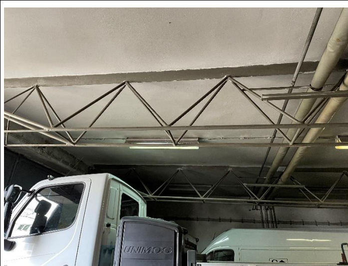
Pohľad na stropnú konštrukciu v garáži
