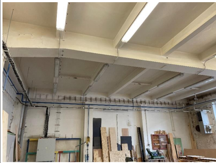
Pohľad na trámový strop nad stolárskou strojovňou
