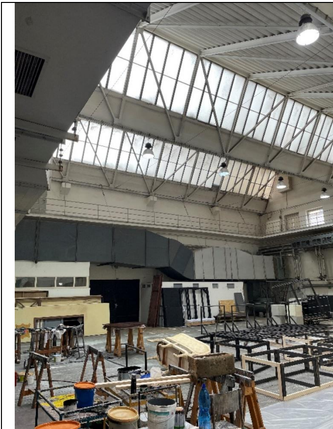
Pohľad na strešnú konštrukciu nad maliarskou dielňou
