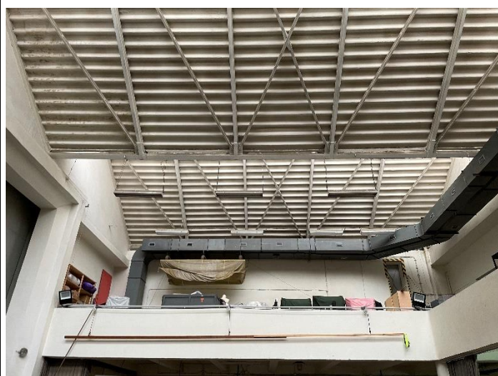
Pohľad na strešnú konštrukciu nad čalúnnickou dielňou
