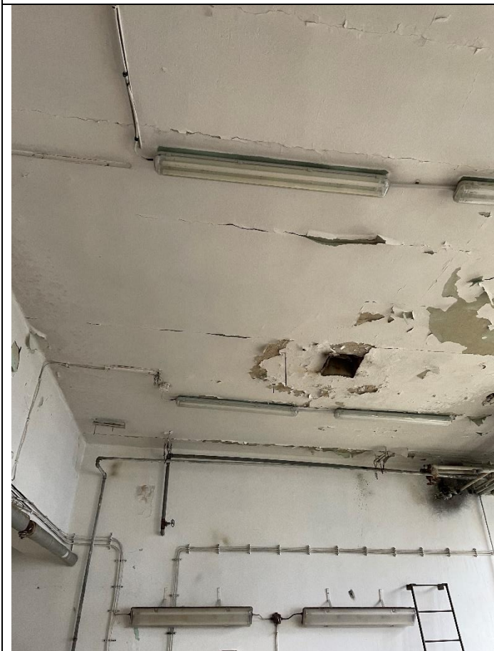
Zatečenie stropnej konštrukcie
