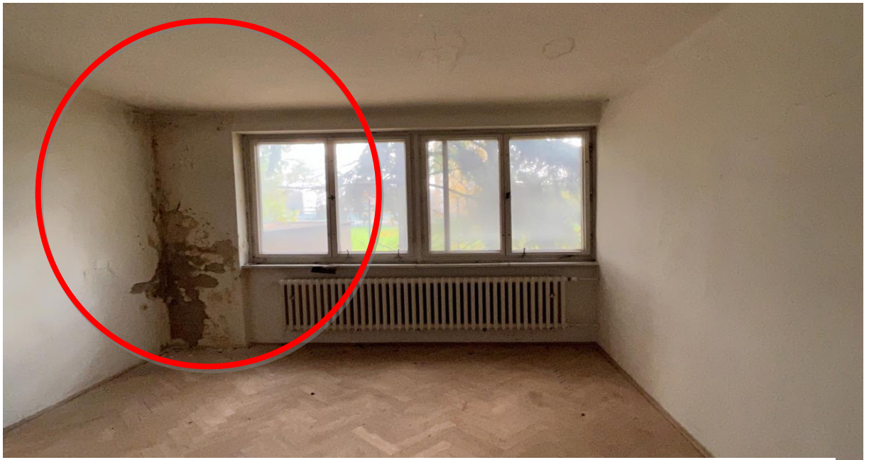
Obrázok 28: Byt správcu / obytná miestnosť s vyznačením miesta zatekania strechy
