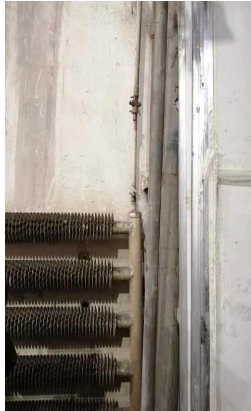
Obr. Pripojenie vykurovacieho registra
