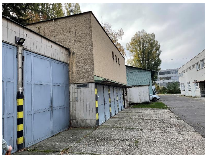
Pohľad z exteriéru na stranu garáže
