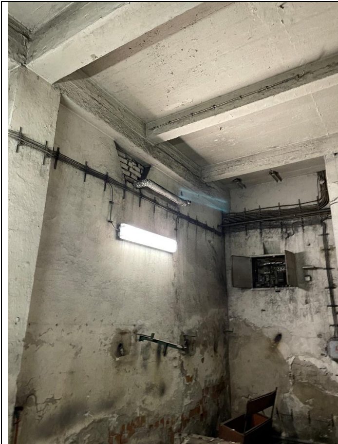
Pohľad na trámový strop nad bývalou kotolňou
