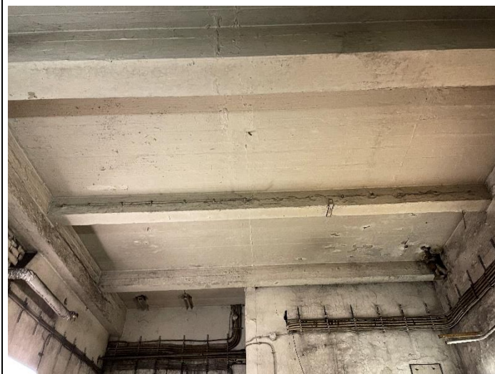
Pohľad na trámový strop nad bývalou kotolňou
