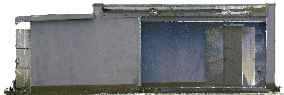
Obrázok 58: Severovýchodný pohľad na technologický objekt
