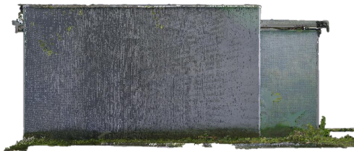
Obrázok 57: Severozápadný pohľad na technologický objekt v mračne bodov
