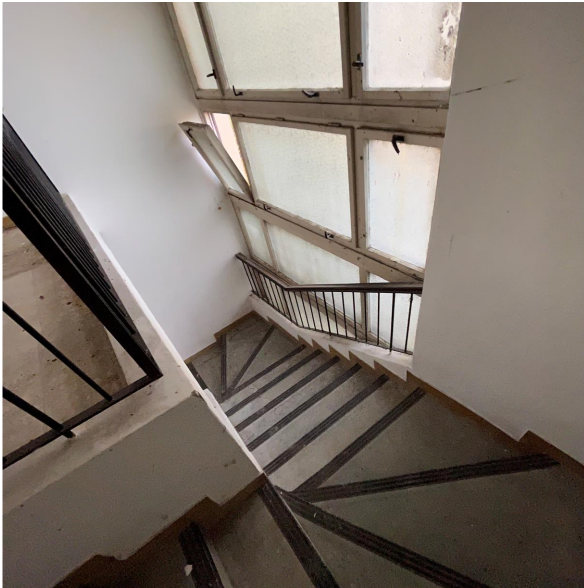
Obrázok 26: Pohľad – Byt správcu / schodiskový priestor
