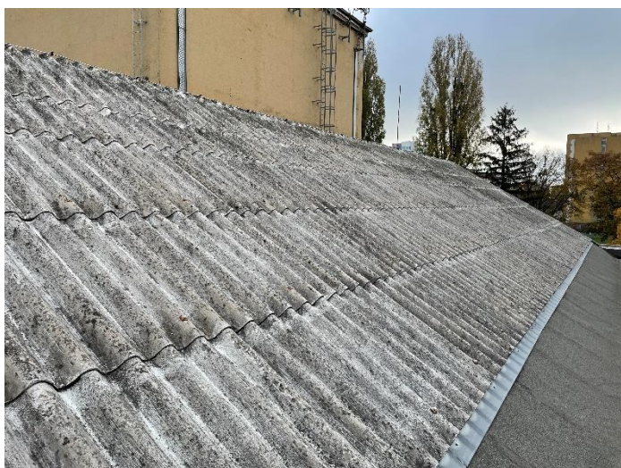
Pohľad na krytinu strechy
