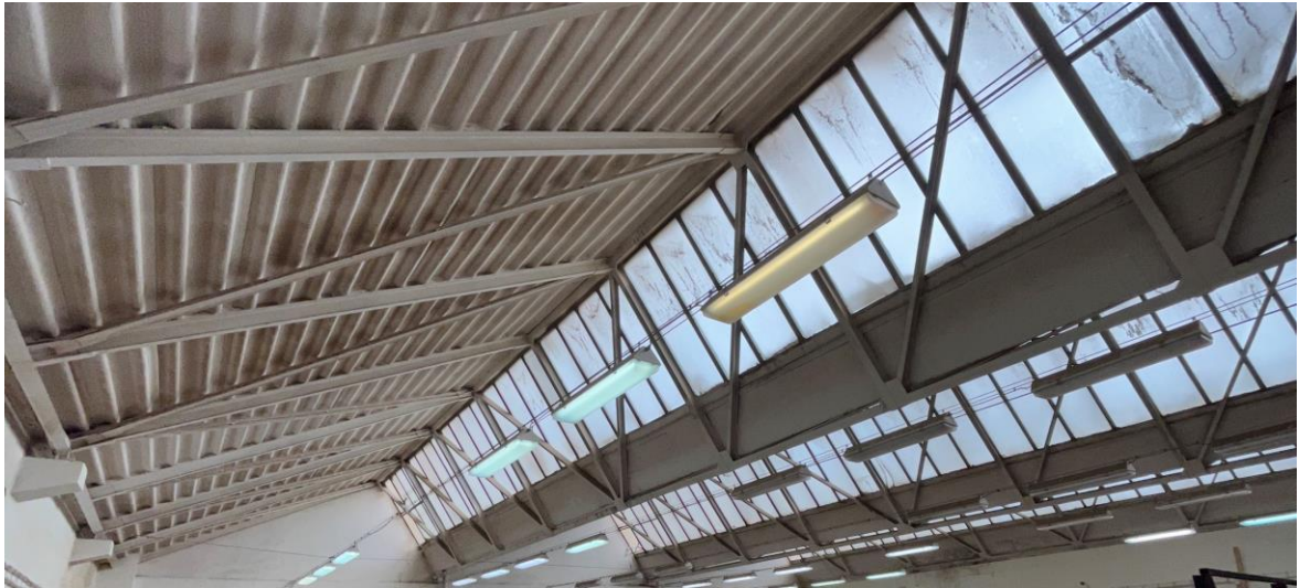
Obrázok 6: Pohľad na konštrukciu píllovej strechy
